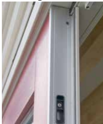
Schuifelementen bedienen grendels aan boven-/onderzijde. Uitslag grendels = 25 mm.
